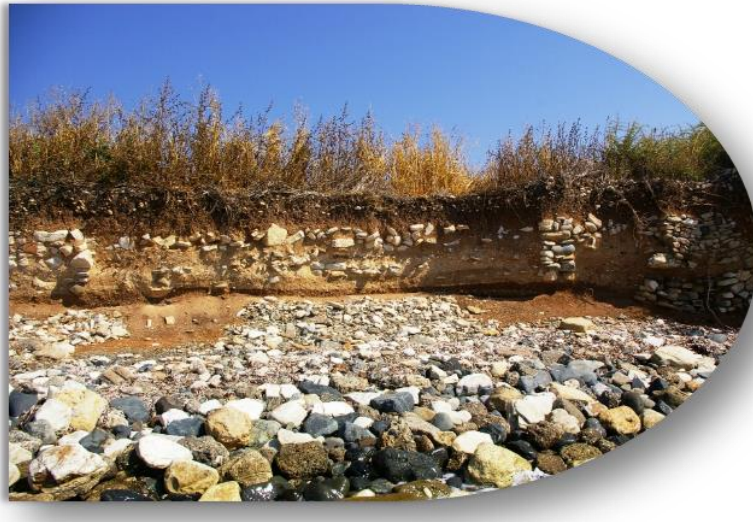
المستوطنة الساحلية توشني لأكيا في قبرص، التي تعود إلى الألفية الثانية قبل الميلاد، تتعرض لتآكل ساحلي، حيث يُقدَّر فقدان الأرض بحوالي 0.5 متر سنويًا. يتفاقم تآكل الموقع وتدهوره بسبب العوامل البشرية، بما في ذلك، على سبيل المثال، التخلص من مخلفات البناء. (الصورة بواسطة Georgia Andreou, 2013)
